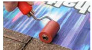
**Beachte:** Der AsphaltWalk Kleber wird durch den Druck des Handrollers aktiviert und verbindet sich mit dem Untergrund. Beim Abrollen mit der Andruckwalze ist darauf zu achten, dass alle Bereiche der Asphaltfolie insbesondere die Kanten erfasst werden (Gefahr der späteren Teilablösung).
