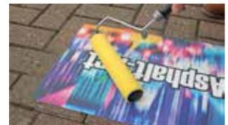
Rollen Sie mit einem härterem Handroller mehrmals über die ganze Folie, um den Kleber zu aktivieren und mit dem Untergrund zu verbinden. Dieser Arbeitsschritt immer sorgfältig und langsam durchführen. Für grosse Verlegeanwendungen verkaufen wir auch grosse Andruckwalzen.
