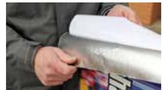
Platzieren Sie AsphaltWalk an der richtigen Stelle und beginnen Sie die von der Schutzfolie entfernte Folie mit einem Handroller auf der Bodenfläche anzubringen.
